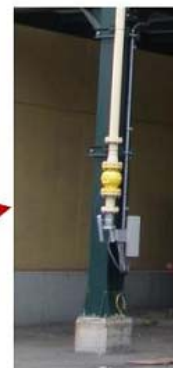
Attacco Serbatoio Depurcal Area produzione rifiuti - Area 13B
