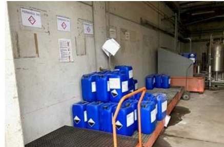
Deposito reagenti impianto Sala pompe - Area 8
